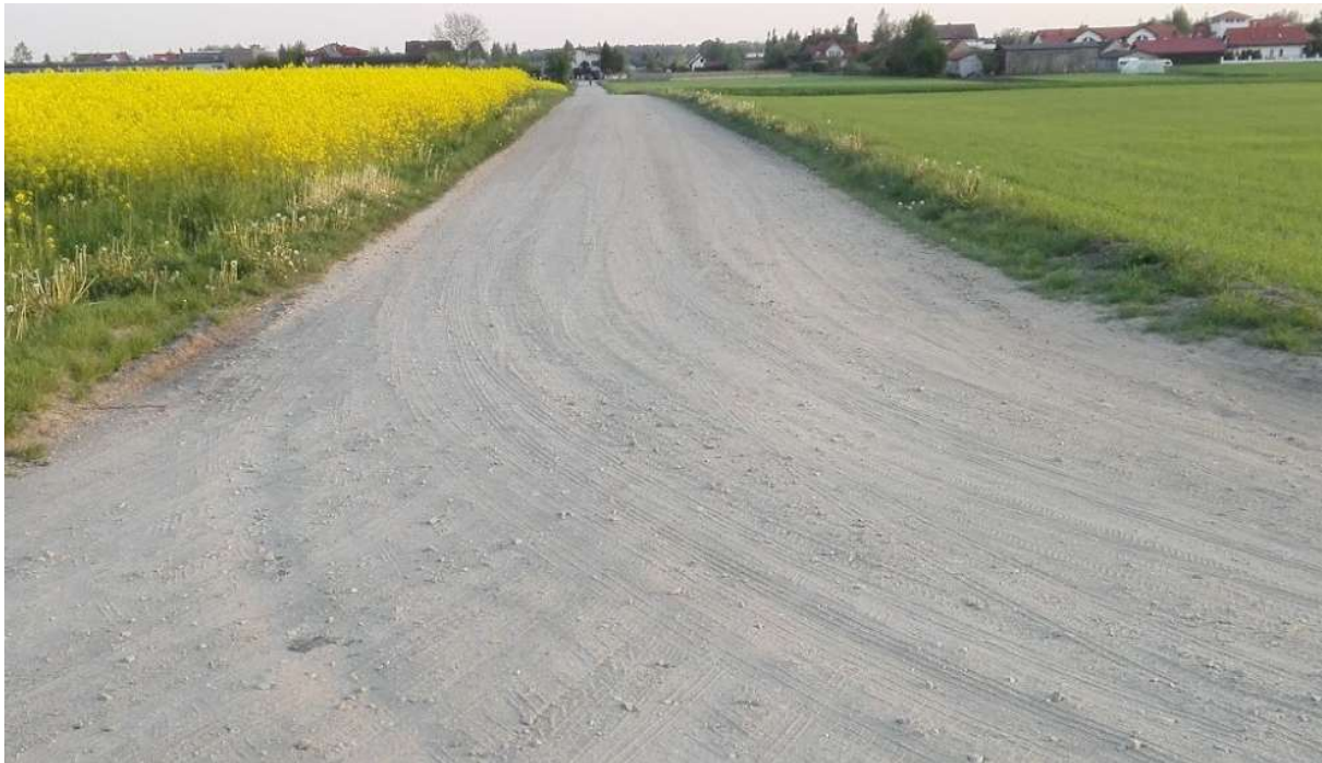
Zdjęcie nr.1 Zdjęcie przedstawia omawianą drogę gruntową.
