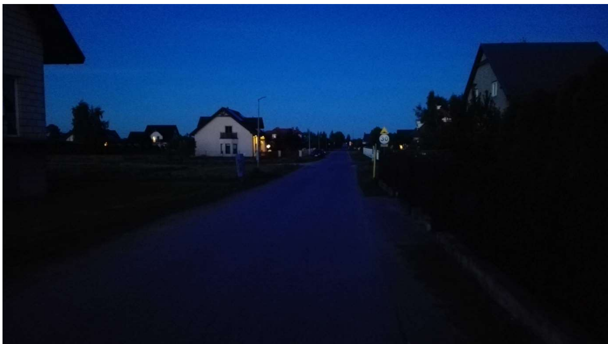
Zdjęcie nr.1 Niedziałające latarnie uliczne na ul. Długiej / 18.05.2022 g. 21:40
