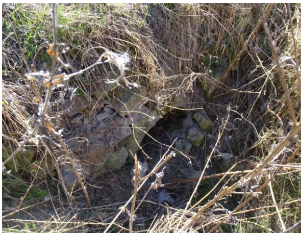
Fot. Istniejący przepust – wiosna.
