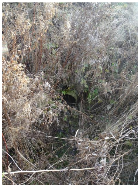
Fot. Istniejący przepust – jesień.
