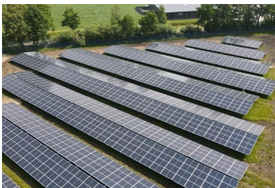
Rys. 6b Gotowa instalacja (układ wschód- zachód)
