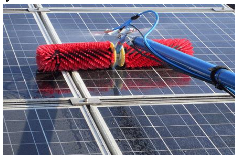
Rys. 9 Czyszczenie instalacji fotowoltaicznej
