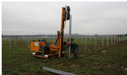
Rys. 2 Palowanie
